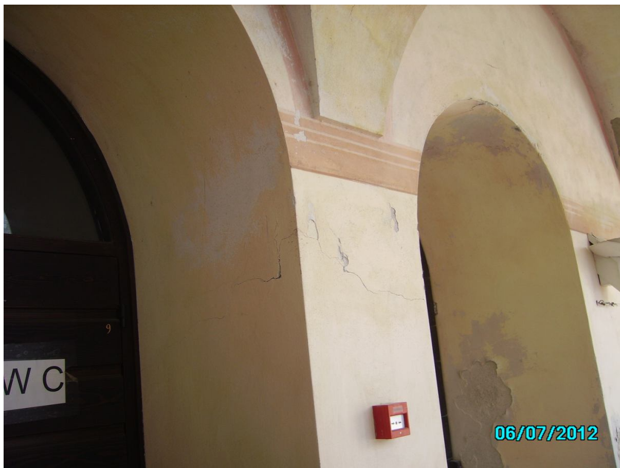
Foto 13 – lesione pilastro nord chiostro Foto 14 - lesione muro vano scale
