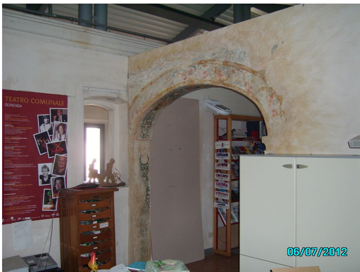
Foto 22 -23 – arco 1° piano lato sud - distacco da muro nord – 2 viste opposte
