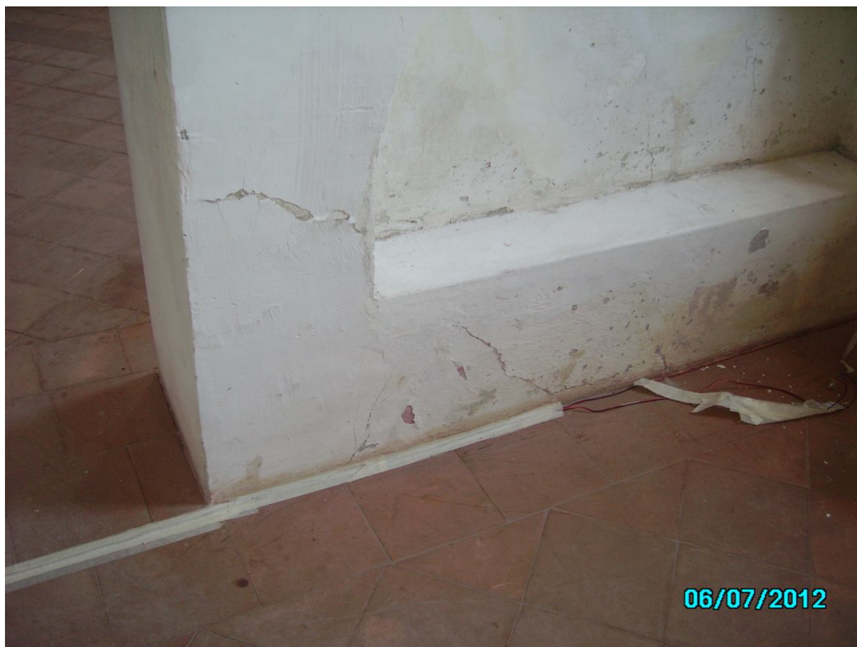
Foto 7 - 8 – lesione sala principale p.t. – lesione piattabanda porta adiacente
