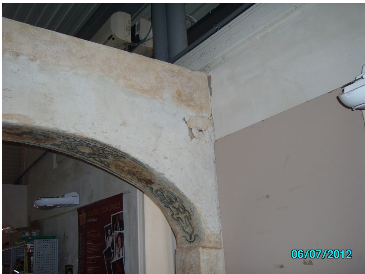
Foto 22 -23 – arco 1° piano lato sud - distacco da muro nord – 2 viste opposte
