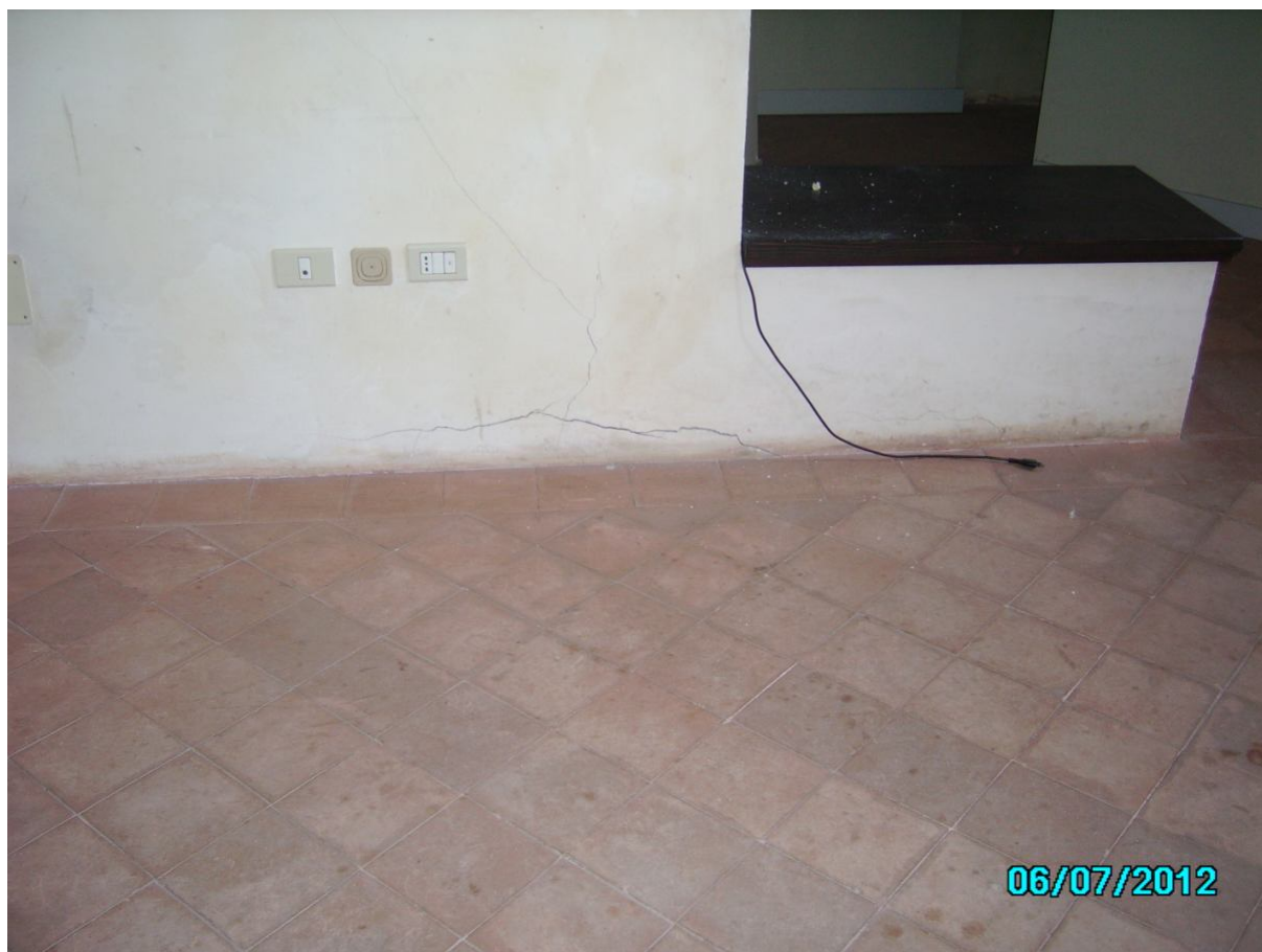
Foto 9-10 – lesioni su murature corrispondenti alle foto 2 (foto sotto) e 5 (lato opposto del muro)
