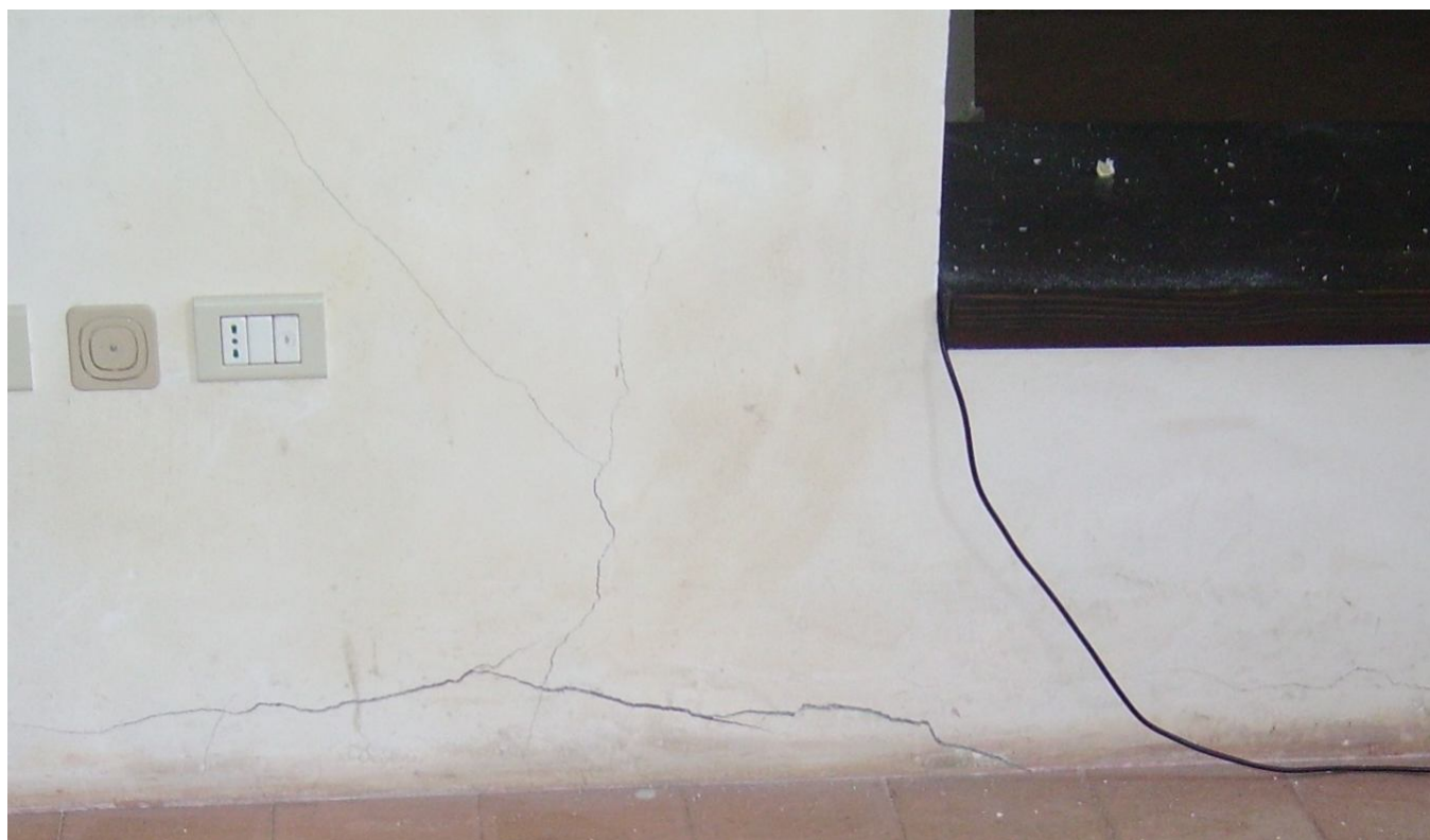
Foto 9-10 – lesioni su murature corrispondenti alle foto 2 (foto sotto) e 5 (lato opposto del muro)
