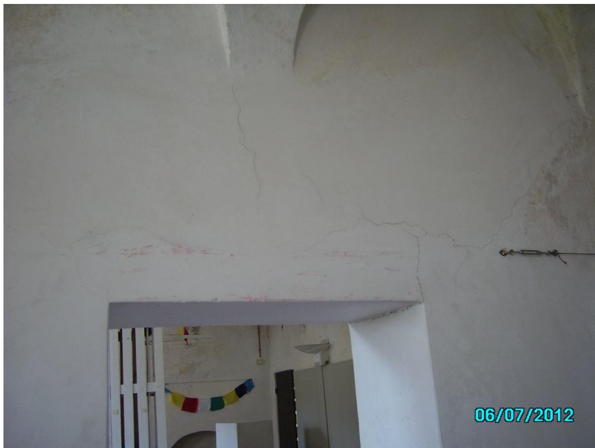
Foto 7 - 8 – lesione sala principale p.t. – lesione piattabanda porta adiacente
