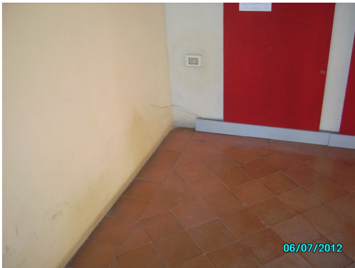
Foto 5-6 – ingresso convento p.t. - lesione sala principale p.t.
