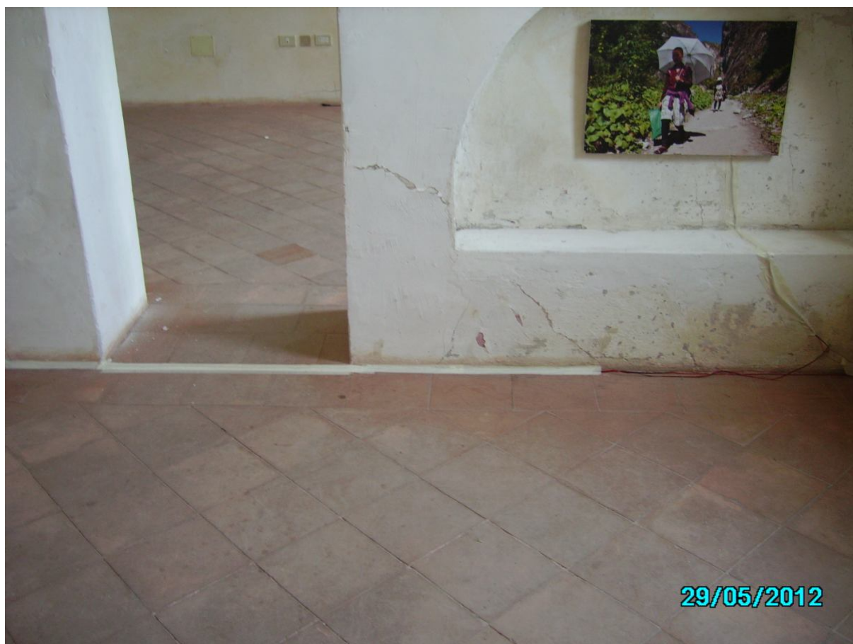
Foto 5-6 – ingresso convento p.t. - lesione sala principale p.t.
