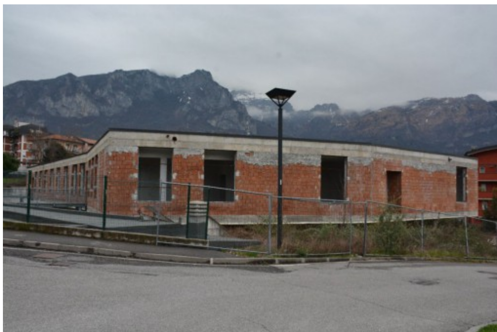
Il cantiere dell'ostello come è attualmente
