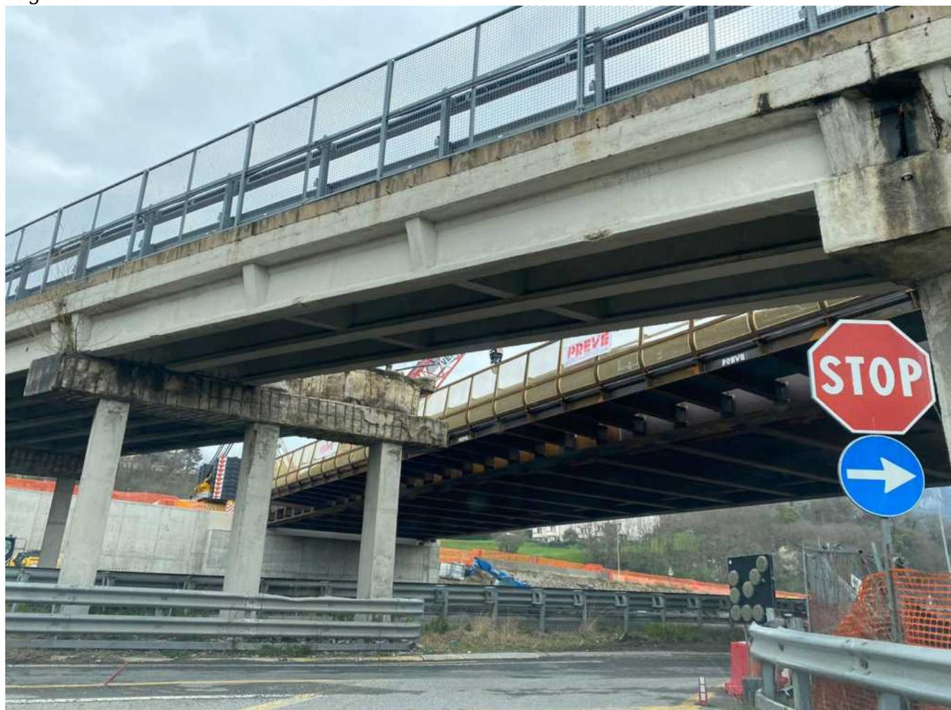
Manca la stesura del manto stradale, con un percorso anche ciclo pedonale l'installazione dell'impianto di illuminazione e delle barriere di sicurezza. Poi il collaudo statico e la riapertura, prevista per giugno.
