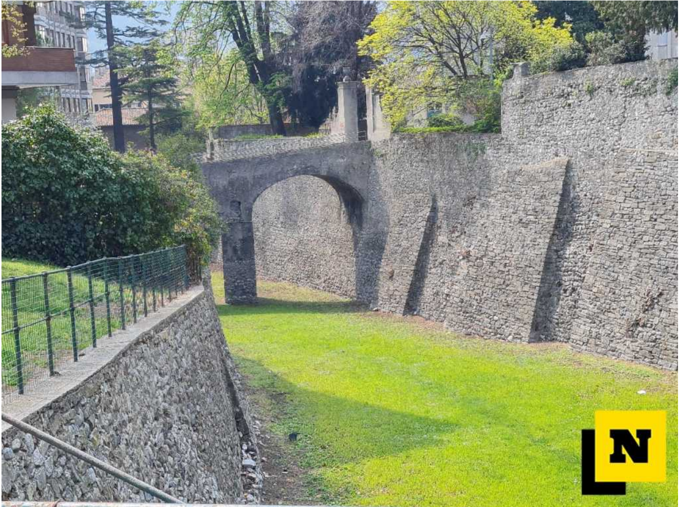
Il ponticello che collega via Volta alla biblioteca
