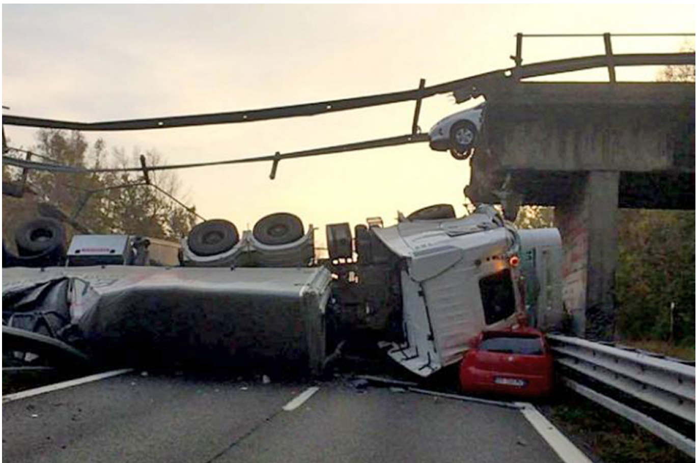
Il crollo del ponte di Annone: era il 28 ottobre 2016
