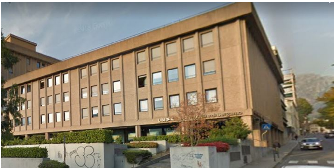
Il palazzo del Centro dell'Impiego
