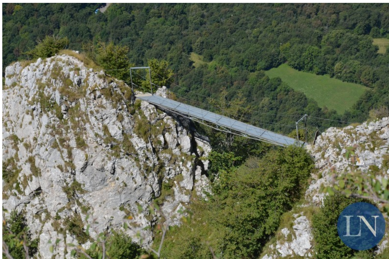
Il ponte della Ferrata Gamma 1
