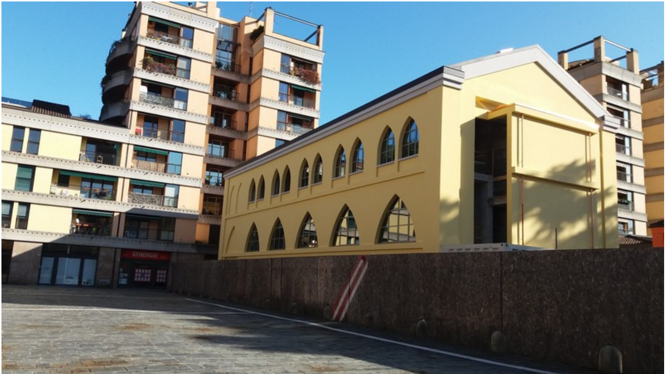
Il retro dell'immobile dopo la ristrutturazione
