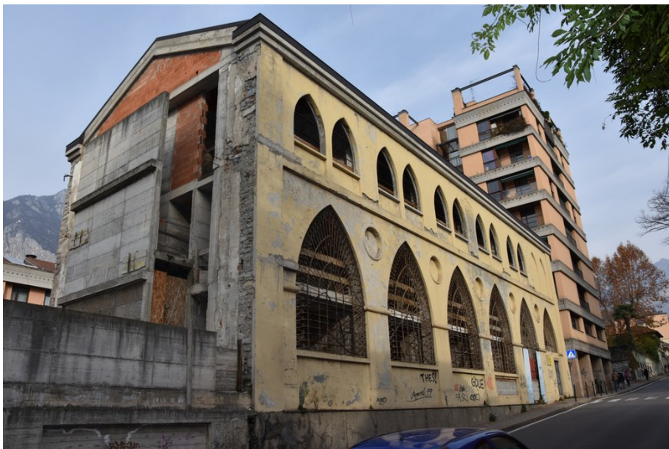
L'immobile prima della ristrutturazione
