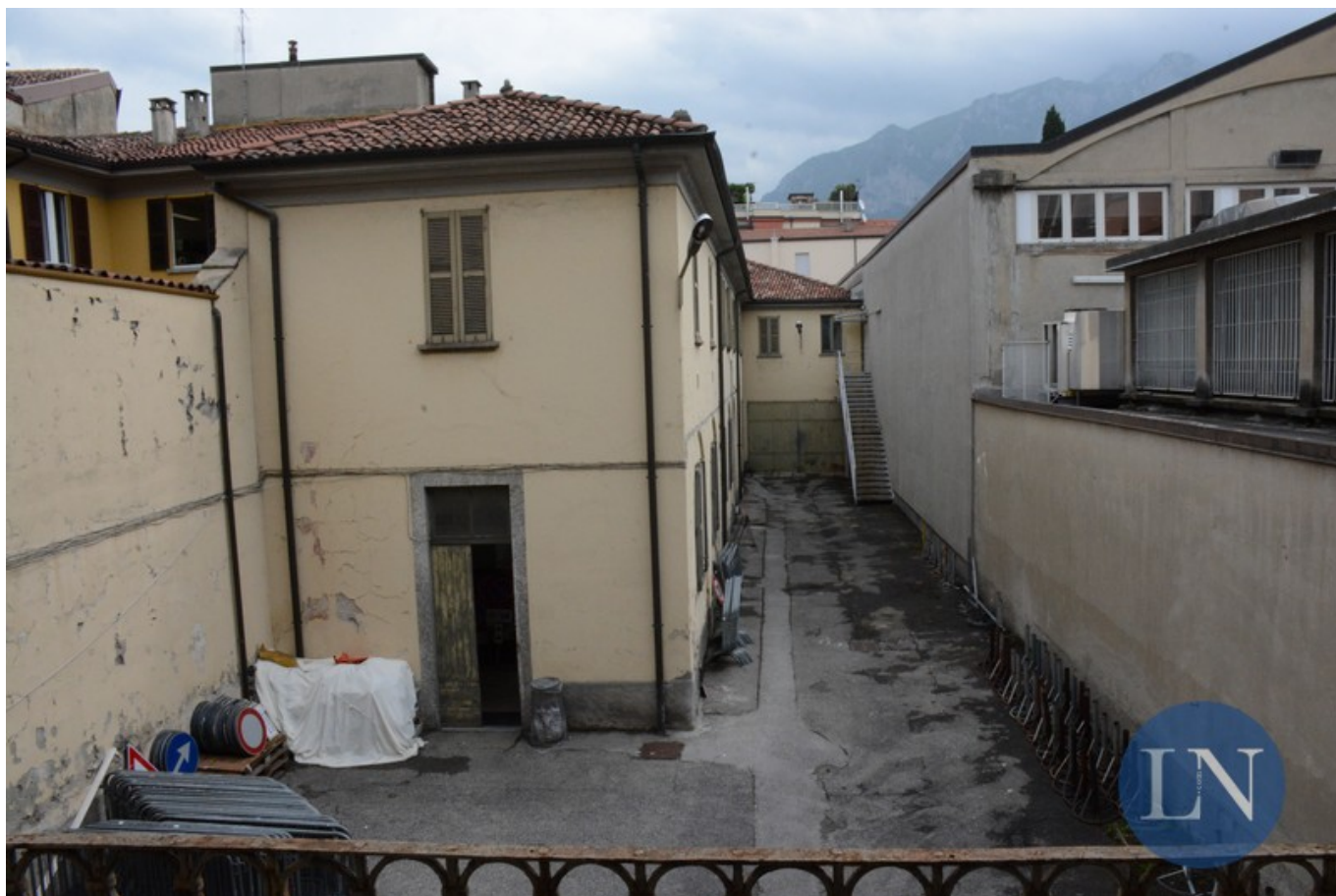
Il corpo fabbrica affacciato al cortile interno
