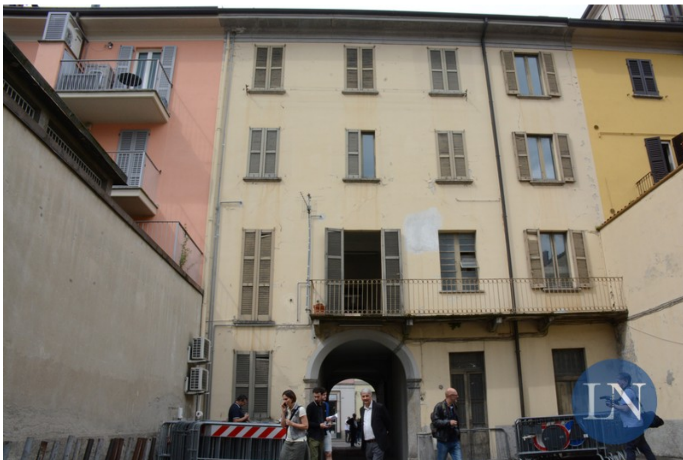
Il corpo fabbrica affacciato a via Roma visto dal cortile interno
