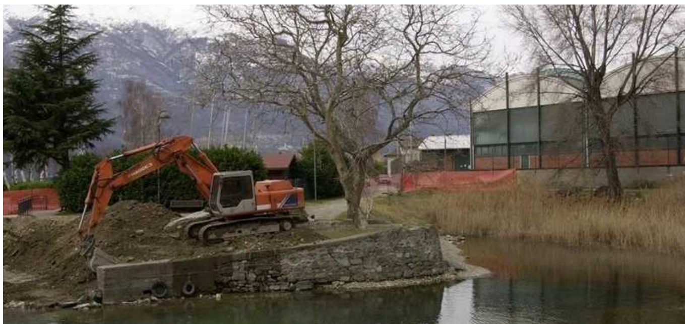
L'area del Fosset di Dervio pre intervento
