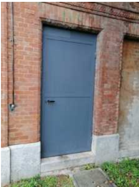
La porta dei bagni della stazione
