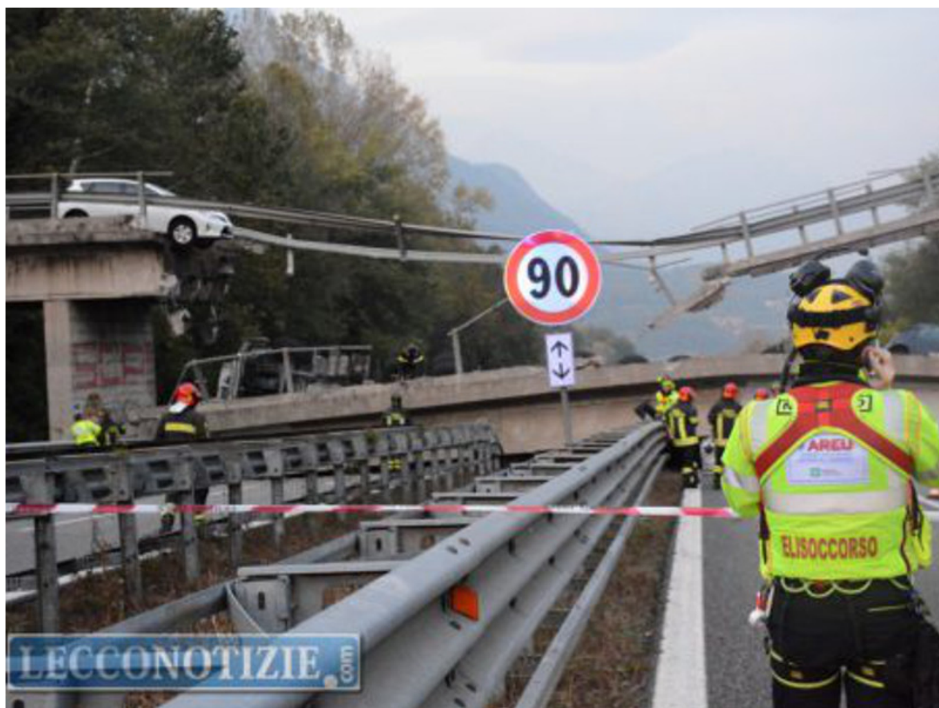
Il crollo del Ponte di Annone: era il 28 ottobre 2016
