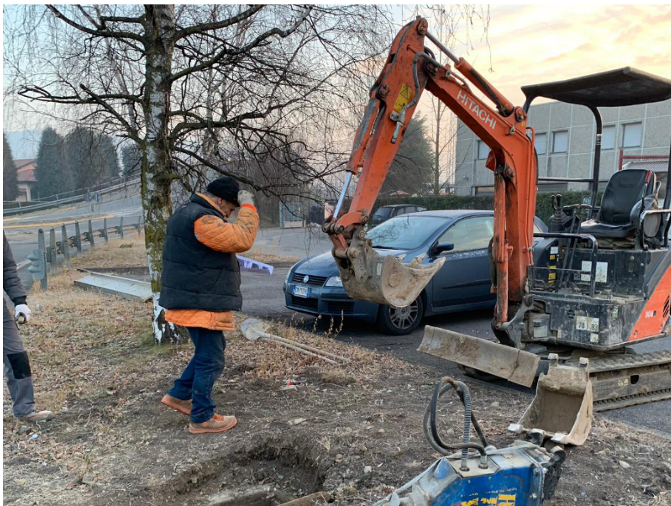
Operai di Enel Sole al lavoro nei giorni scorsi
