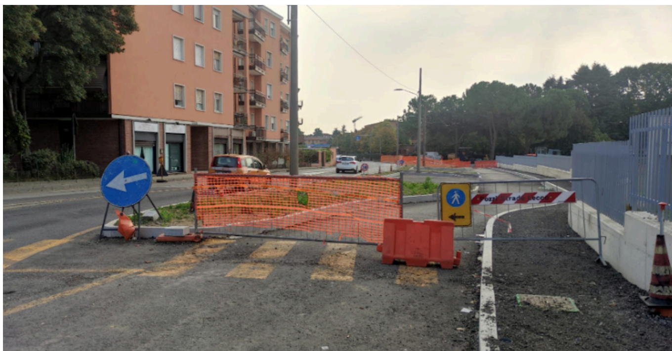
L'accesso alla nuova area di parcheggi in fase di realizzazione
